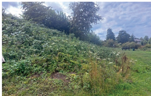
Figuur 64 De taluds van de fortheuvel zijn grotendeels verruigd met dijkvlitbraam en struiken. Foto Kees Goudsmits.
