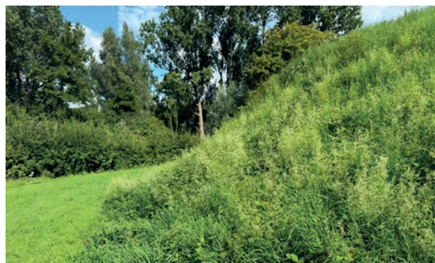
Figuur 69 Een deel van de taluds van het fort verruigt met brandnetel en braam. Foto John Smit.
